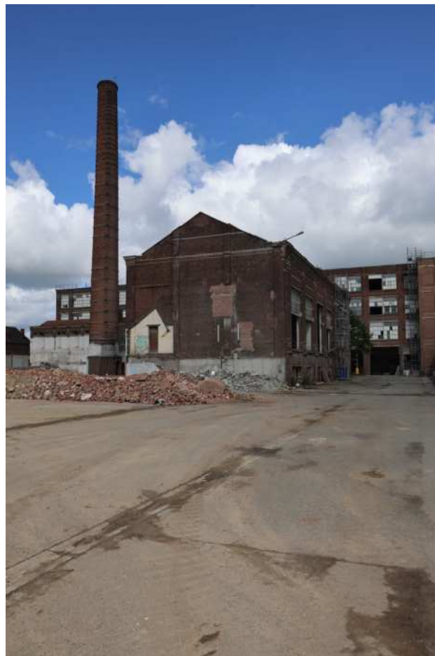
Confortement de la filature Lepoutre
