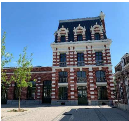
Gare de Tourcoing : la Ville va engager en 2023 le processus de requalification intérieur des locaux vacants au sein du bâtiment voyageurs
