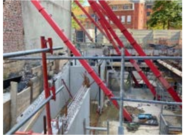
Début Août 2021 Création d'une paroi berlinoise Avancement du Gros Œuvre en sous sol et retrait des boutons à l'avancement du GO
