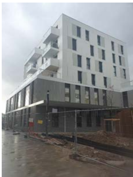
Octobre 2022 : Les logements sont livrés et les travaux sur l'équipement s'achèvent.
