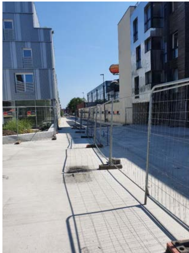
La réalisation de la rue du Haze
