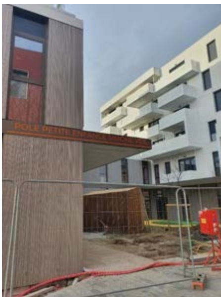
Novembre 2022 : Les travaux du pôle petite enfance Simone Veille touchent à leur fin.
