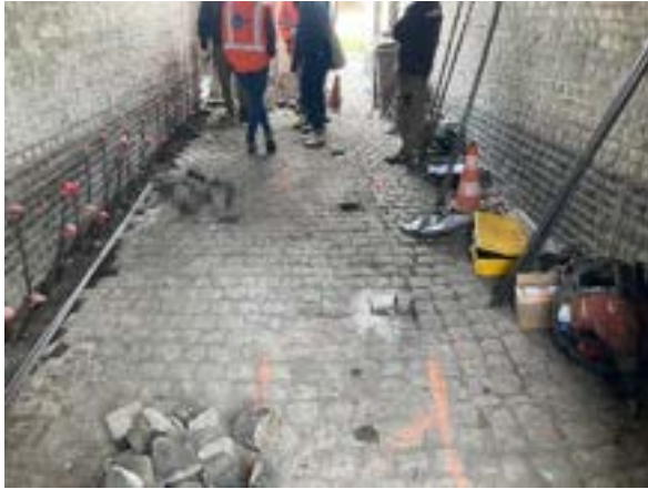
22 Juin 2021 Travaux d'injection de résine au 13 rue Dewyn
