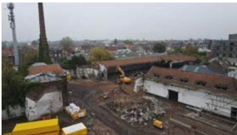
Novembre 2021- Démolition du site Masure
