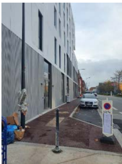
Octobre 2022 : Finalisation des travaux sur le trottoir de la rue du Docteur Dewyn
