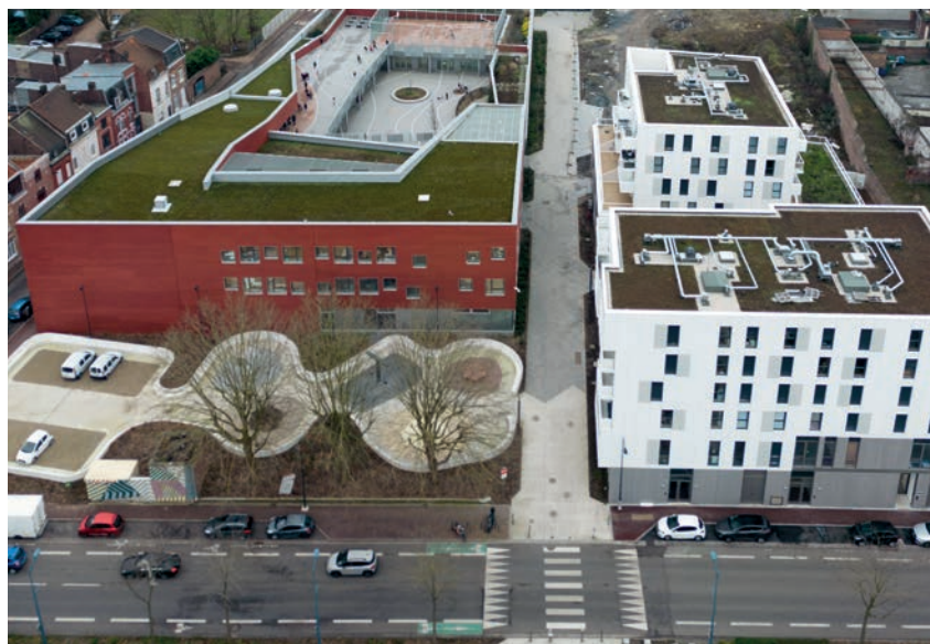
Quadrilatère des Piscines
