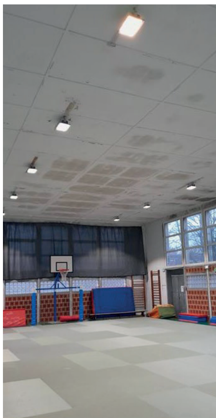
Remplacement de l'éclairage dans la salle de sports Édouard Herriot
