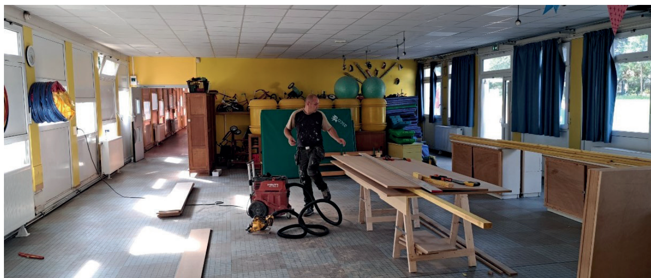
Travaux dans l'école Branly
