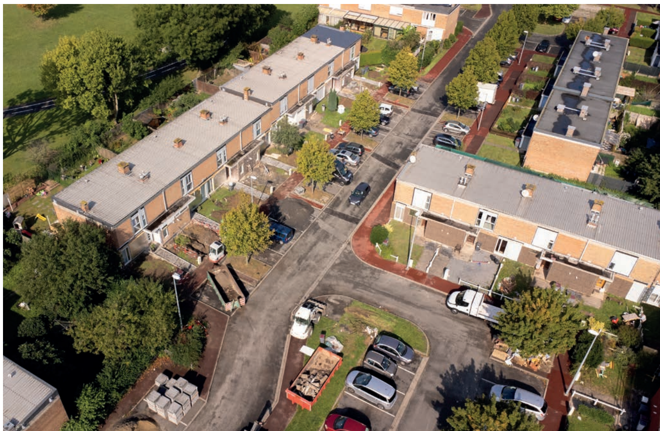
Rénovation du quartier de la Bourgogne
